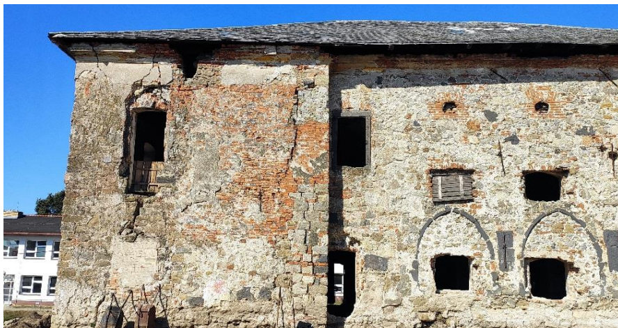
Obr. 7 – Východná fasáda s poškodenými, resp. chýbajúcimi omietkami
