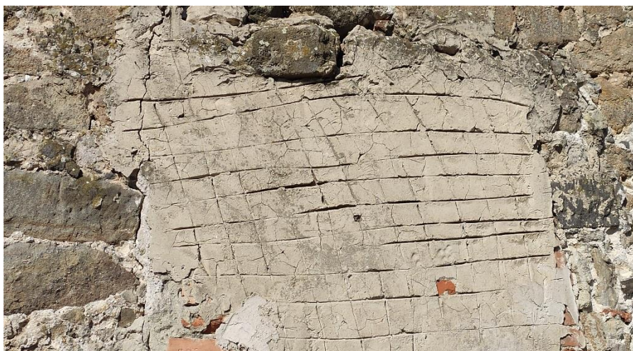
Obr. 9 – Nevhodné opravy cementovou omietkou
