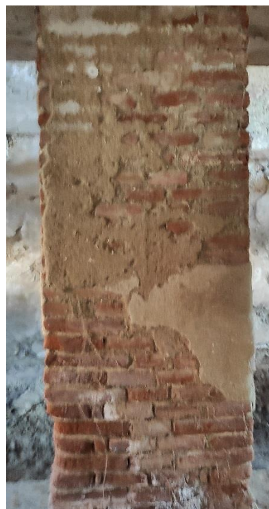
Obr. 19 – Poškodenie pilierov vzliňajúcou vlhkosťou a soľami
