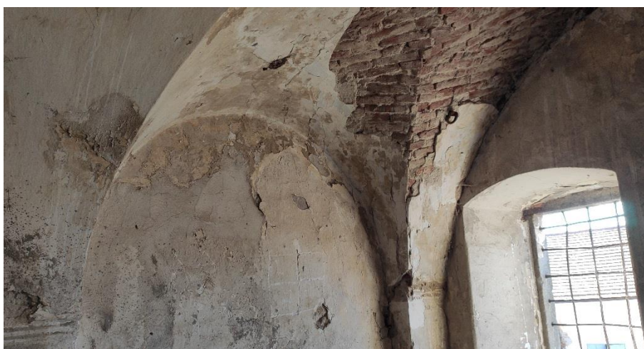
Obr. 22 – Vlhkostné mapy zo zatekania z úrovne stropu
