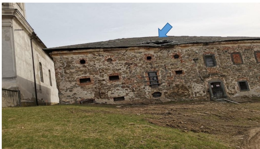
Obr. 1 – Zatekanie cez porušenú strešnú krytinu (foto z 03/2021)
