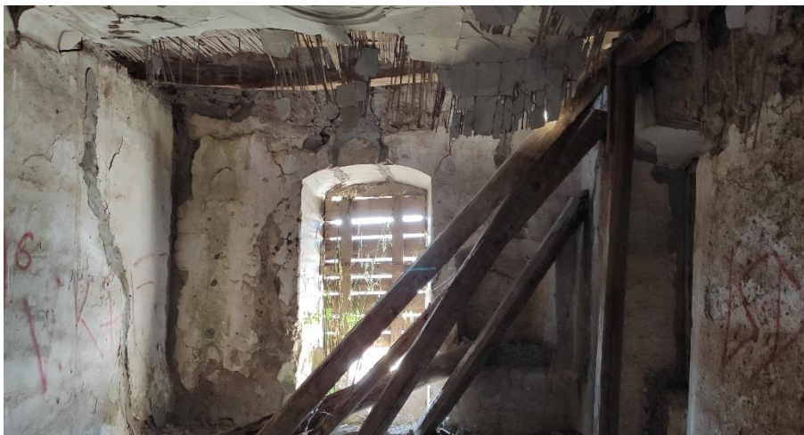
Obr. 17 – Zrútený trámový strop nad 2.NP
