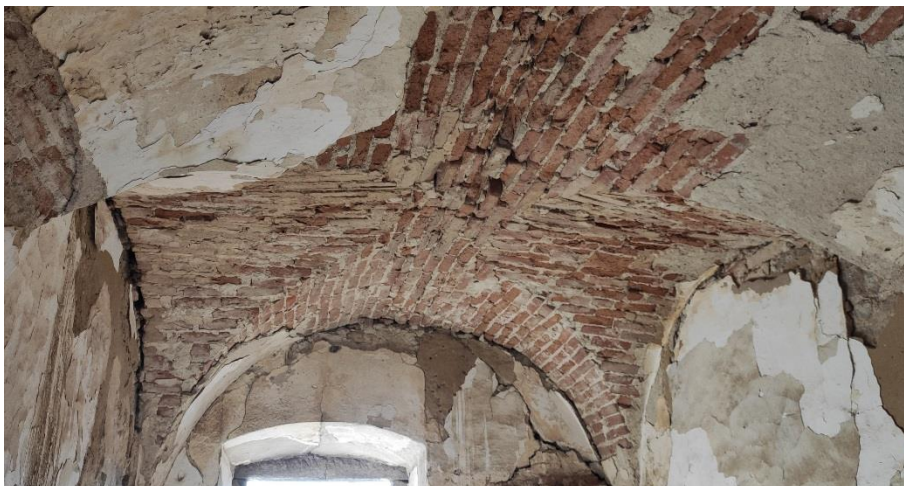
Obr. 14 – Rozpad muriva klenby a omietok poschodia vplyvom mrazov
