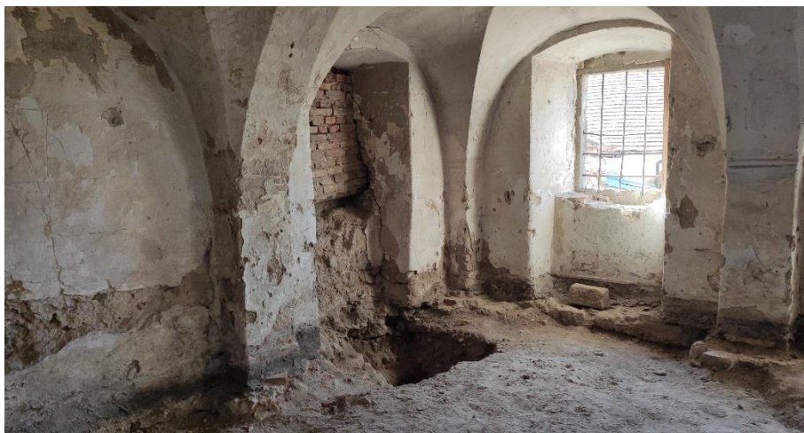
Obr. 26 – Poškodené povrchové úpravy v obytnej časti
