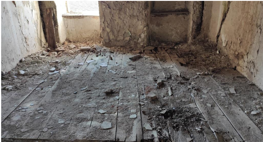
Obr. 17 – Poškodenie drevenej palubovej podlahy na poschodí
