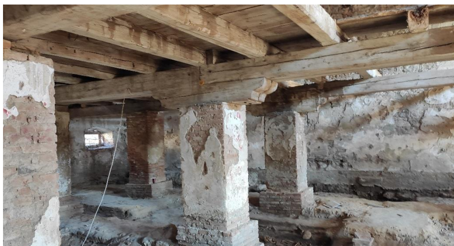
Obr. 21 – Zatekanie z vyšších úrovní v časti drevenej vstavby sýpky
