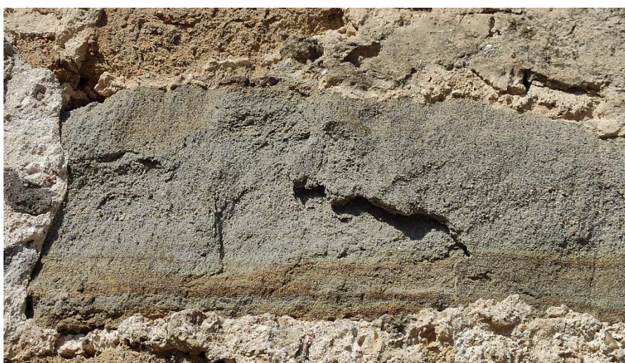
Obr. 2 – Zvetranie kamennej hmoty obvodového muriva
