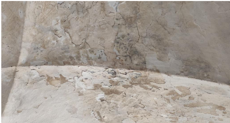
Obr. 23 – Vlhkostné mapy a zaplesnenie omietok
