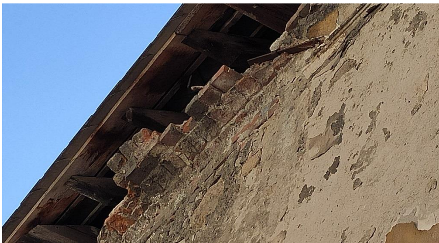
Obr. 8 – Rozpadnutá tehlová korunná rímsa poškodená zatekaním zo strechy
