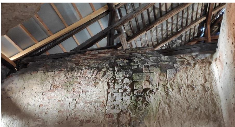
Obr. 13 – Rozpad koruny muriva a omietok zatekaním zo strechy pred opravou
