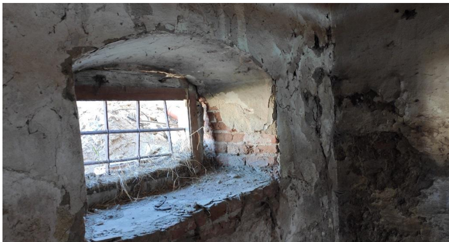
Obr. 25 – Priame zatekanie zo zvýšeného terénu cez okenný otvor
