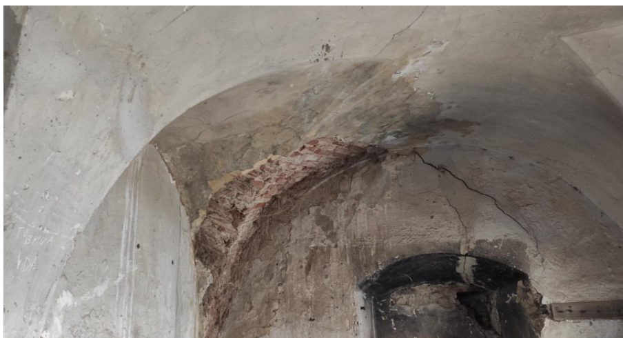
Obr. 24 – Poškodenie zatekaním z oblasti strechy a 2.NP
