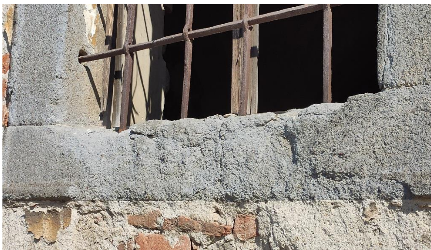
Obr. 3 – Degradácia kamennej hmoty parapetu okna
