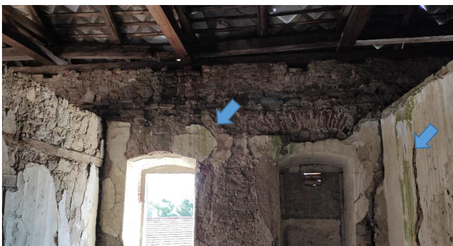
Obr. 16 – Biologická korózia povrchov stien na poschodí
