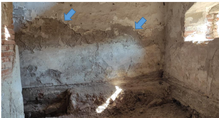
Obr. 20 – Degradácia omietok v odparovacej zóne
