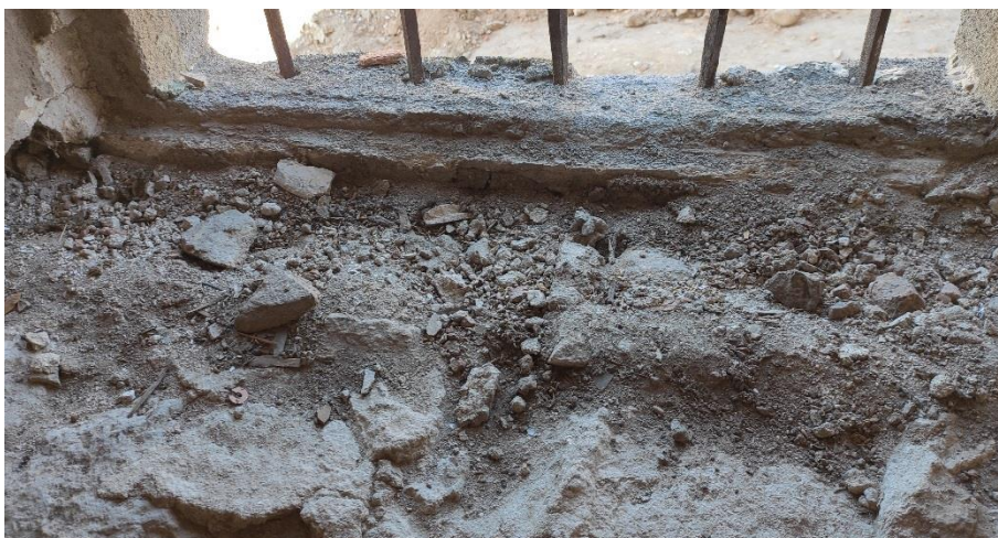
Obr. 15 – Rozpad muriva parapetu intenzívnym zatekaním cez okenný otvor
