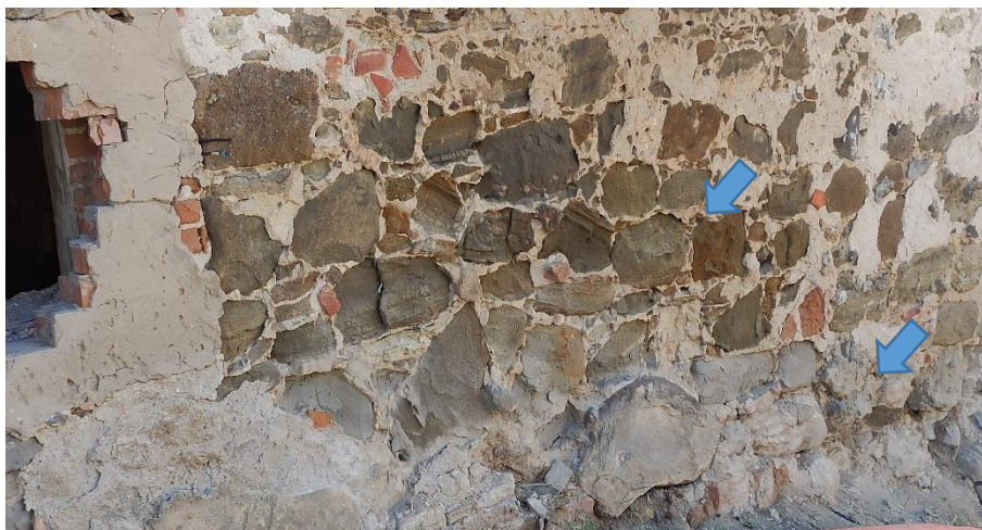
Obr. 12 – Poškodenie omietok a kamenného muriva v oblasti nad soklom pôsobením mrazov
