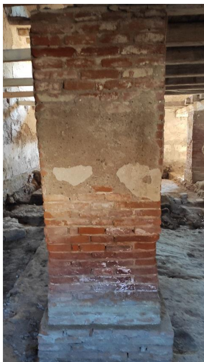
Obr. 19 – Poškodenie pilierov vzliňajúcou vlhkosťou a soľami
